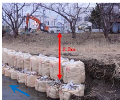
図-3 錦橋直上流津波痕跡
