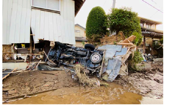
千曲川の決壊箇所(長野市穂保) 近隣の細粒泥に厚く覆われた住宅地の被害状況(2019年10月15日) 筆者撮影
