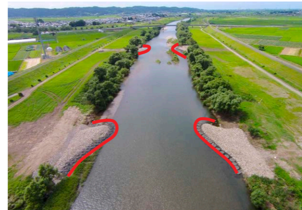
早出川に設置された縮小工法(2016年7月20日) 赤線部分が4つ1組となるように設置した縮小工法 撮影：国交省阿賀野川河川事務所
